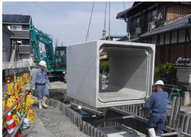
雨水管渠埋設状況
