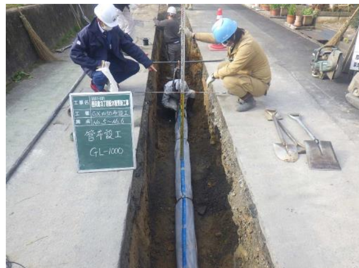
管路更新工事の様子
