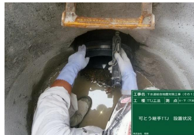
マンホールと下水道管接続部の耐震化施工状況
