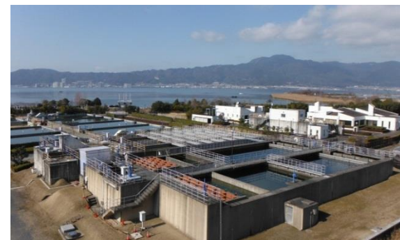
北山田浄水場
