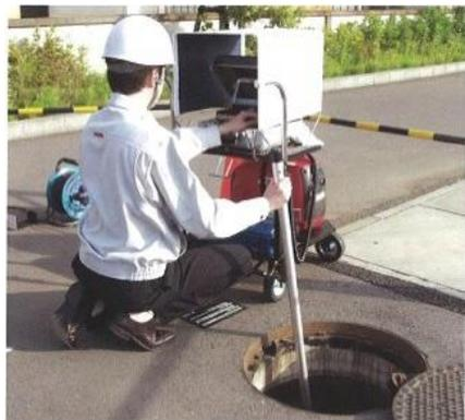
下水道ストックマネジメント計画に基づき施設の老朽化・地震リスクの大きさに応じて点検調査を実施のうえ、老朽化が見られる箇所については、計画的に更新事業を行っています。
