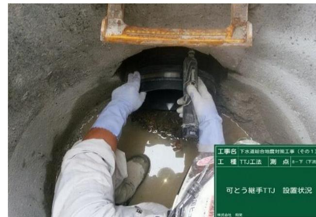
マンホールと下水道管接続部の耐震化施工状況
