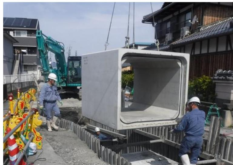
雨水管渠埋設状況
