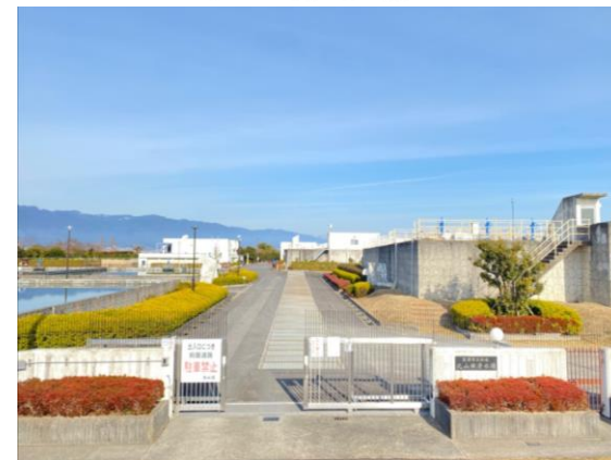
北山田浄水場
