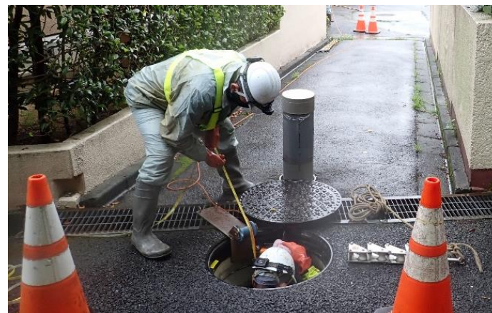
不明水調査状況
