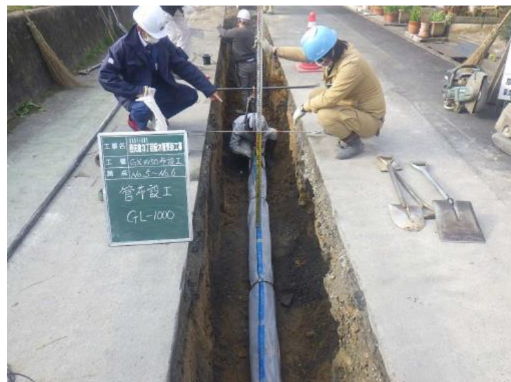
管路更新工事の様子
