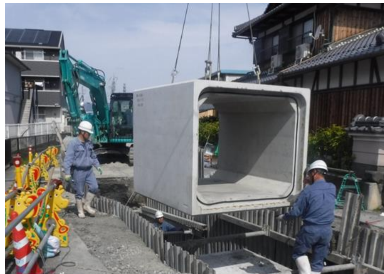
雨水管渠埋設状況
