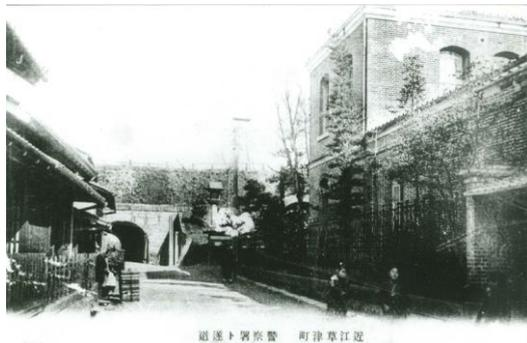
明治19年(1866)に作られた草津川の隧道は、アーチ式煉瓦両側石積み、長さ 43.6m、高さ 3.6m、幅 4.5m で、道路は少し掘り下げられた。そのため、左側の民家は石積みをし、石段を数段上って入る。右手の2階建ての建物は、翌20年に完成した警察署。
