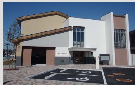
老上西まちづくりセンター完成の様子
