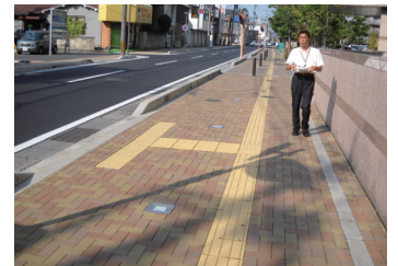
横断歩道がない箇所に設置された誘導用ブロック
