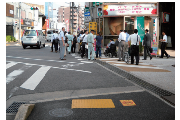
動線からずれて設置された横断歩道
