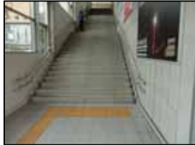
南草津駅の階段の状況
