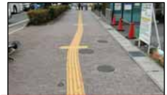
誘導用ブロックが緩やかなカーブで設置
