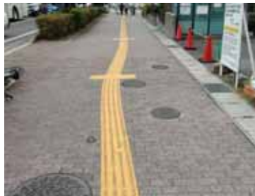
車両乗り入れ部（駐車場） （歩道が連続している）
