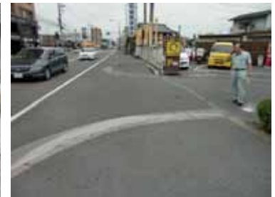
市道との交差部 （歩道が途切れている）
