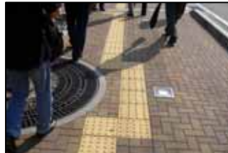
×誘導用ブロックがジグザグ
