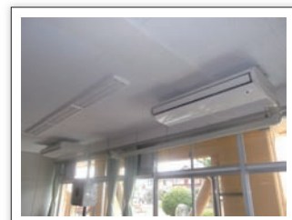
幼・小・中学校にエアコンを設置
