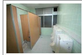
小・中学校のトイレの改修
