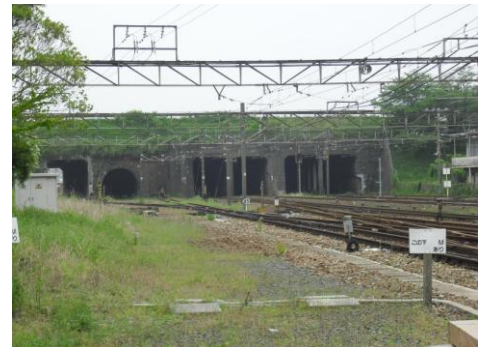
JR草津駅から天井川であった旧草津川の堤体をのぞむ
