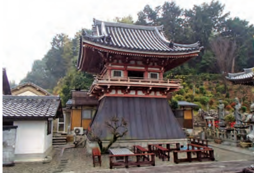
▲西方寺(青地町)の鐘楼(県指定有形文化財)
