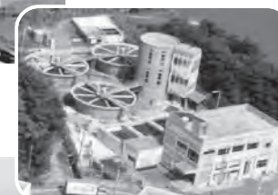
▲ ロクハ浄水場完成
