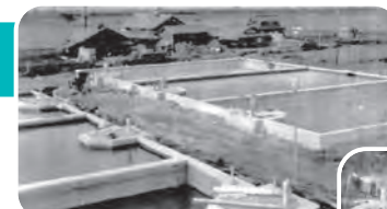
▲ 北山田浄水場完成
