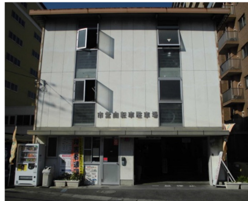
○草津駅西口自転車駐車場
