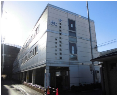
○草津駅東自転車駐車場
