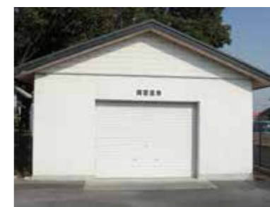
↑ 防災びちく倉庫
