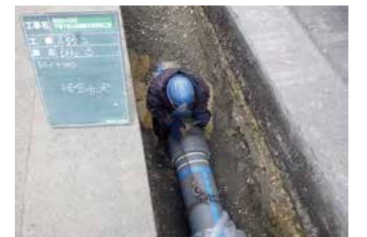
配水管の取替えの様子
