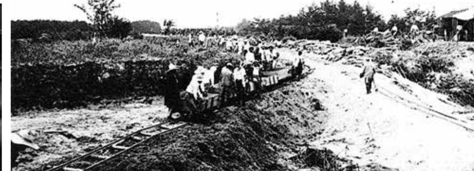
1938(昭和13)年、大雨で、ていぼうが切れた草津川を直す様子
