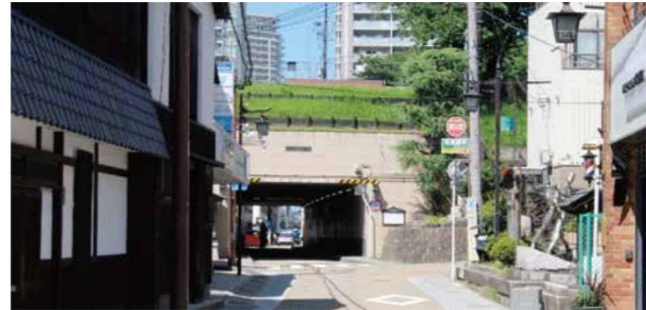
↑現在の草津マンポの様子 草津1丁目と大路1丁目の間にあるトンネルで「草津マンポ」とよばれています。
