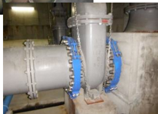
フランジ補強施工イメージ
