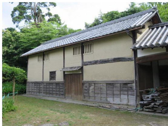
倉(保存修理工事対象建物)
