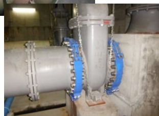
フランジ補強施工イメージ
