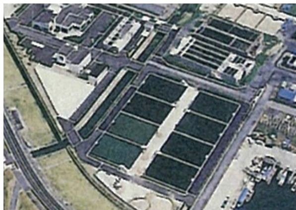
北山田浄水場
